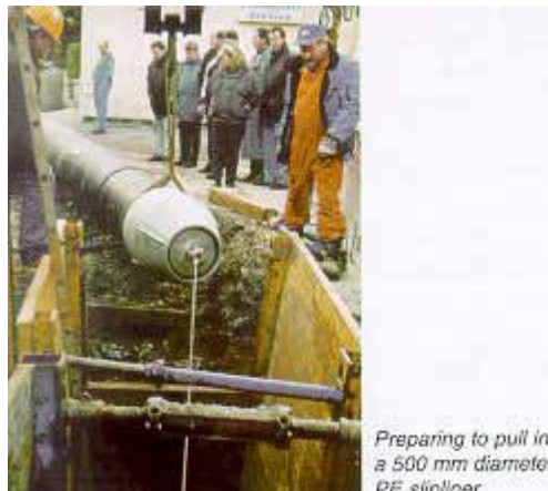
500 mm çaplı olan bir PE kayarak kaplamanın çekme işlem için hazırlanması
