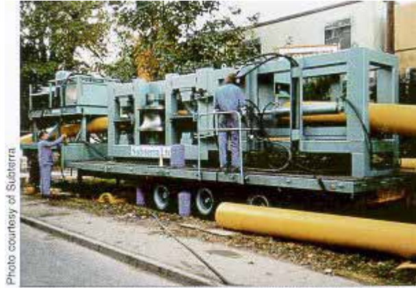
Machine for simultaneously reducing the diameter of a PE pipe and inserting it into the host pipeline Bir PE borusunun çapının eş zamanlı olarak daraltılması ve de ana boru hattı içerisinde yerleştirilmesi için kullanılan makine
