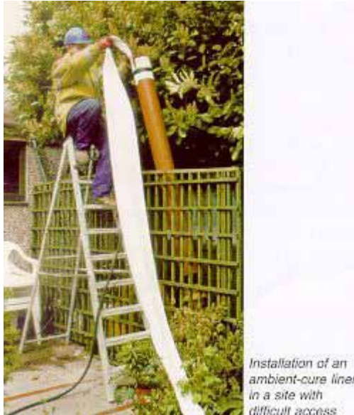
Ortam sıcaklığında sertleşen bir kaplama malzemesinin erişimi zor olan bir yere monte edilmesi
